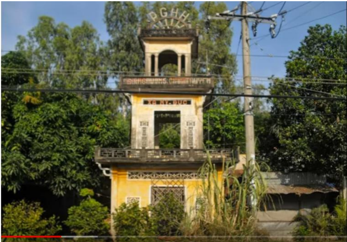
ĐGD hoang phế tại xã Mỹ Đức, quận Châu Phú, tỉnh Châu Đốc (nay là An Giang).
